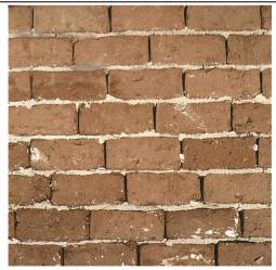
Dettaglio di odierno paramento di làdiri, posato in opera con il classico sistema "a blocco" ed usando malta di terra stabilizzata con grassello di calce.
