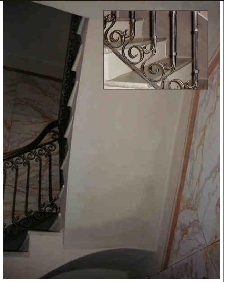
La realizzazione classica del tipo di scala in muratura è quella delle voltine alla romana; una struttura che sfrutta il sistema spingente dell'arco per divenire invece "rampante".
