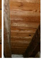
Sopra da sinistra, veduta dall'intradosso di un'orditura lignea semplice con travi ad interasse costante; al centro, dettaglio di una trave appena sbozzata e del tavolato inchiodato su di essa; a destra, particolare di un interasse piccolo per sovraccarichi più sostenuti.
