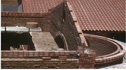
Finiture di colmo di un neo-apparato murario in terra cruda, pronto a ricevere in canali a scomparsa le nervature in cemento armato, nel rispetto della moderna normativa.
