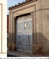
Per i portali selargini non era più usato il sistema "pesante" con architrave primigenio (ligneo), ma nel secondo quarto del Novecento la tipologia è stata reintrodotta usando l'architrave monolitico in cemento armato. Sono ancora presenti nel C.S. i segni della sua introduzione al posto dell'arco in terra cruda.
