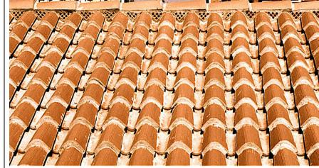
Le tegole in cotto industriale: per il tetto "ventilato" bioclimatico (fori in alto nel colmo)
