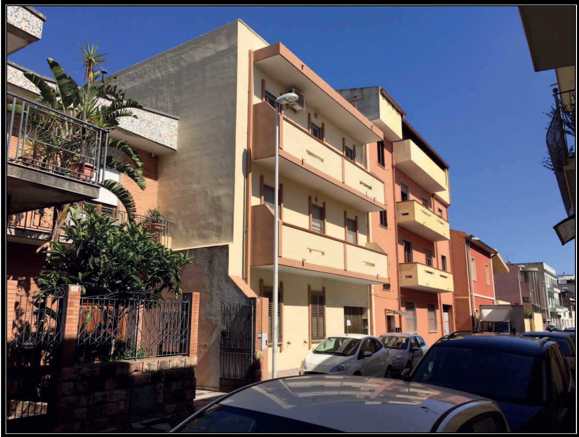
Foto n° 5 – Fabbricato confinante destro (Via Firenze civ. 55-57 e precedenti)
