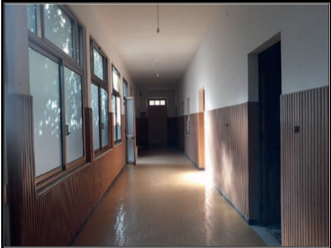
FOTO n° 8 – Vista interna disimpegno
