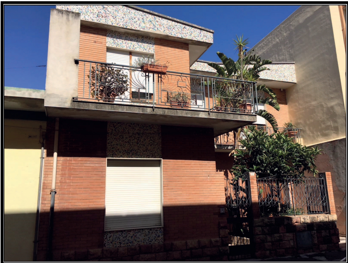
Foto n° 4 – Fabbricato confinante destro (Via Firenze civ. 55-57)
