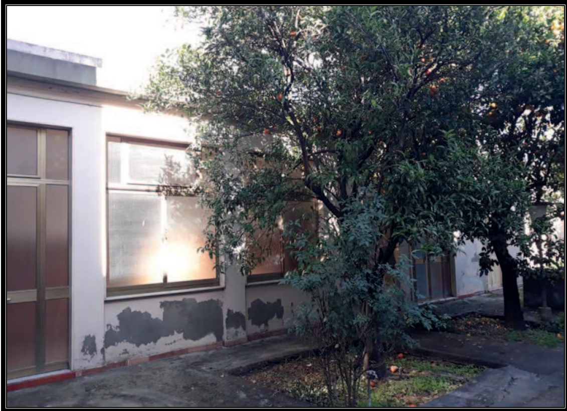
FOTO n° 7 – Vista fabbricato esistente dal cortile
