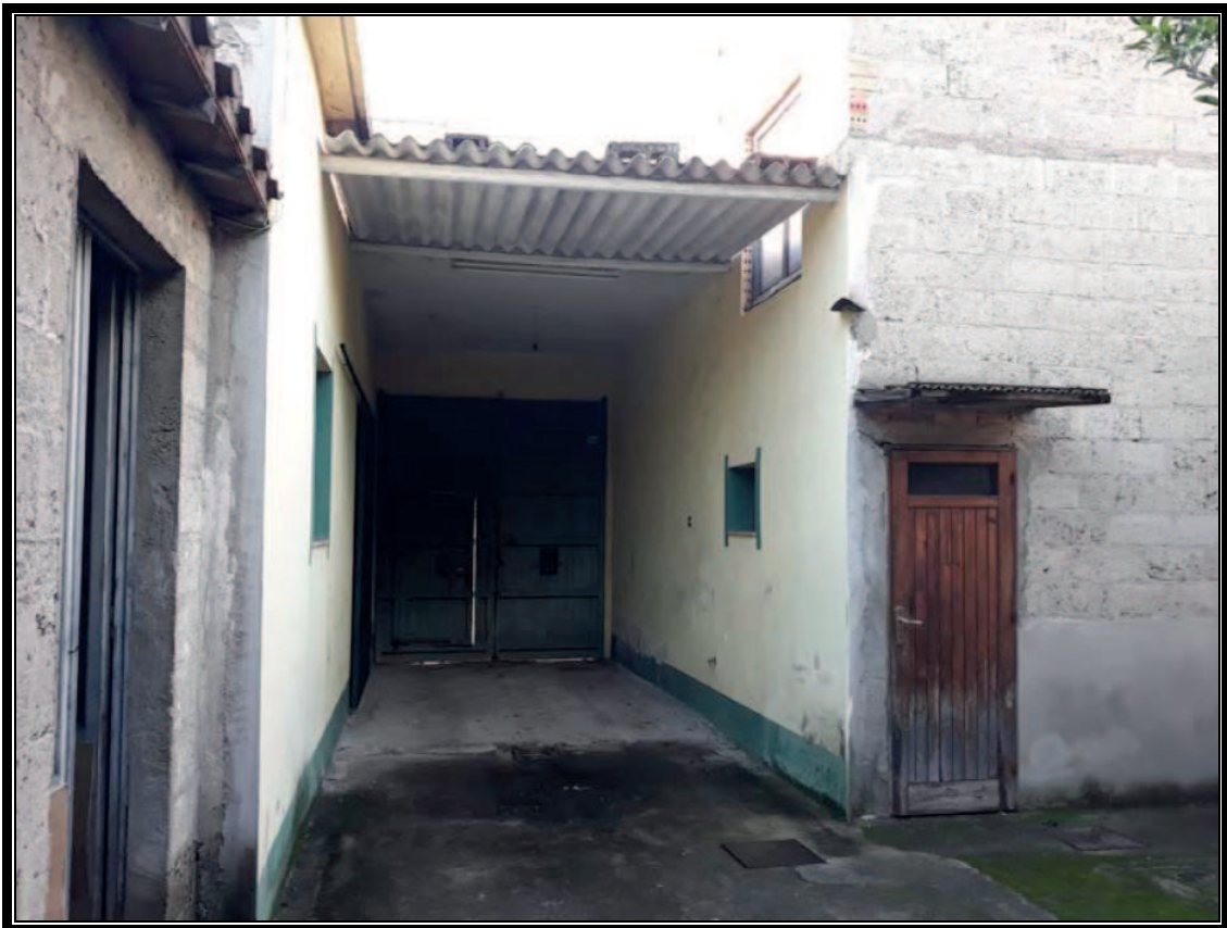
FOTO n° 6 – Vista fabbricato esistente (dal cortile verso il portone di ingresso)
