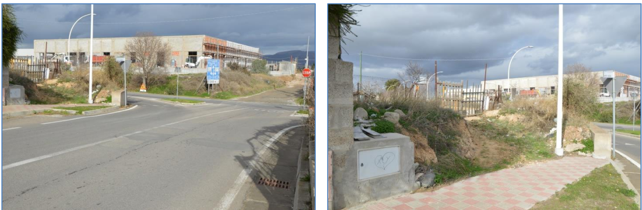
Fig. 23 e 24. Via delle Azalee. Sulla sinistra, in corrispondenza della rampa di accesso, si realizzerà un marciapiede; Per la realizzazione del marciapiede si asporterà parte della terra oggi contenuta dal muro in cemento armato. [Foto DSC_3586 da SW; DSC_3590 da SW]
