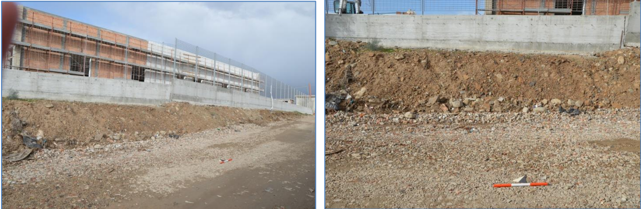
Fig. 17 e 18. Strada sterrata. Limite SE del lotto di MD Immobiliare. Si noti la differenza di quota tra il piazzale e la strada; Dettaglio della sezione. [Foto DSC_3559 da SW; Foto DSC_3560 da SE]
