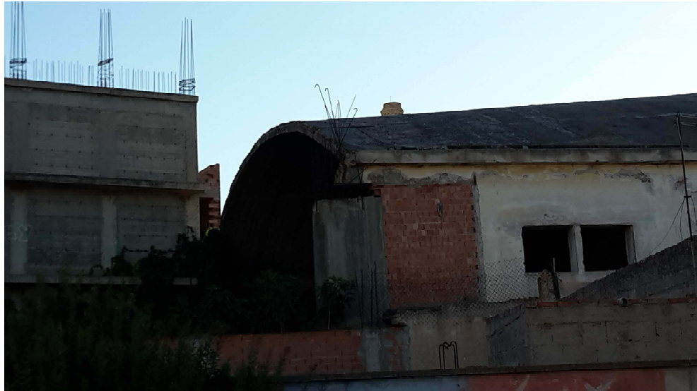
Foto n. 3 Vista dell'ex cinema Astra. Vista del corpo spogliatoi e della volta del cinema.
