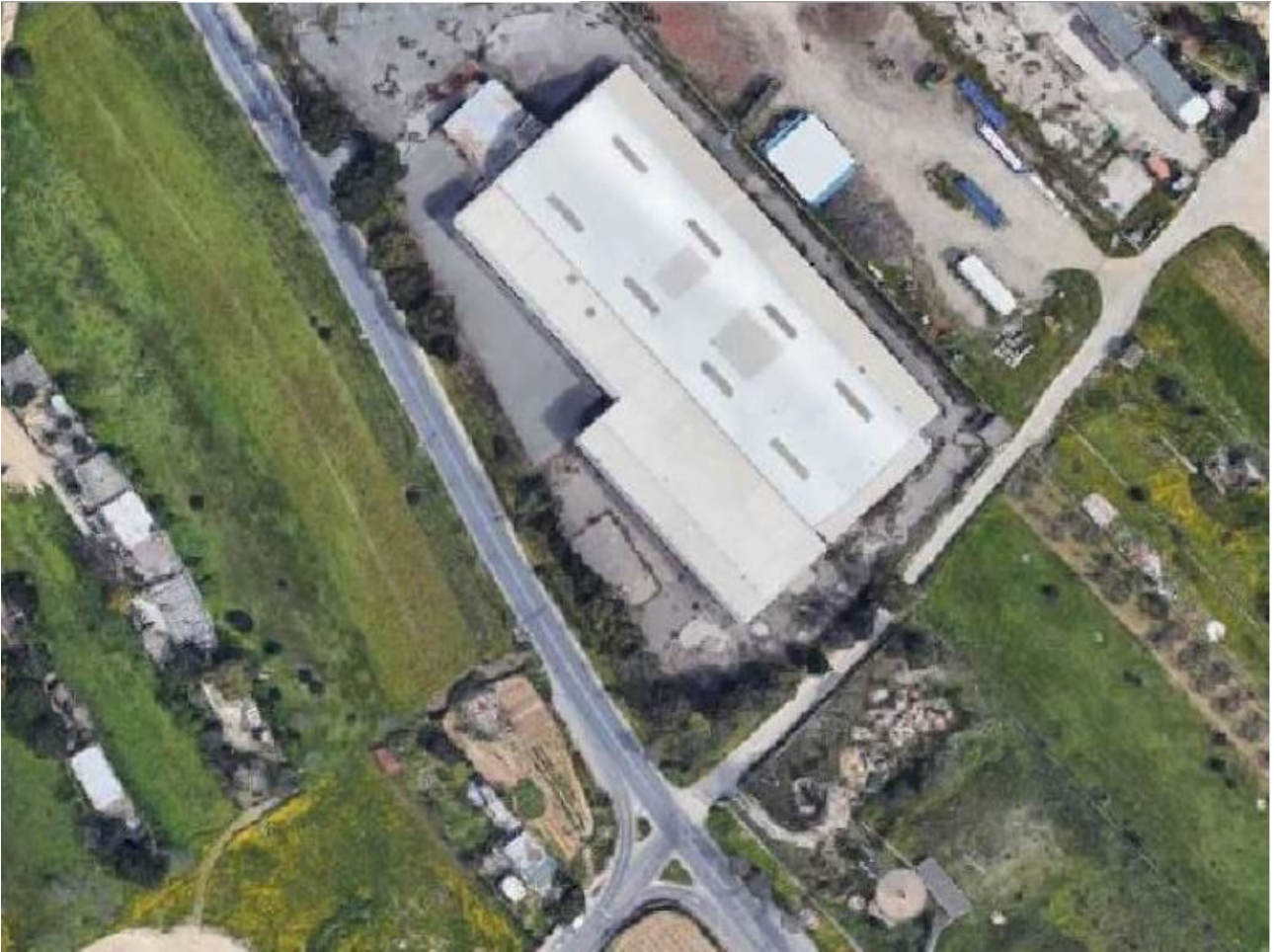
Aerofoto stato attuale (nella foto è ancora presente il fabbricato in fase di completamento e in parte già completamente ristrutturato), in basso al centro è visibile l'incrocio che andrà sostituito dalla rotonda.
