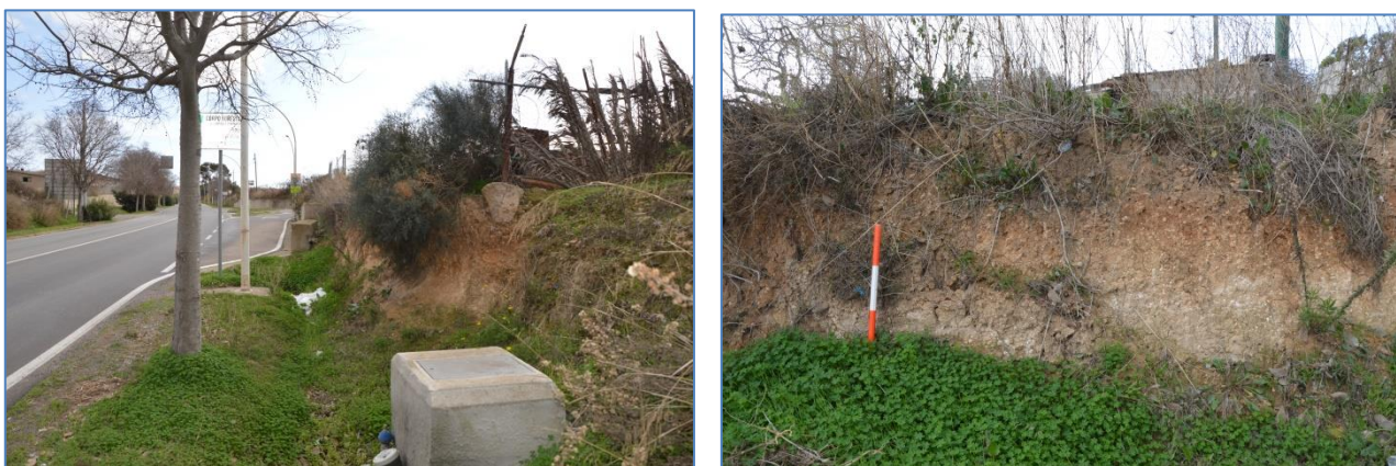
Fig. 25 e 26. Via Nenni. Spazio per la realizzazione di un marciapiede in corrispondenza della rampa di accesso per via delle Azalee; Dettaglio della sezione terrosa prospiciente via Nenni. [Foto DSC_3593 da NW; Foto DSC_3595 da N]
