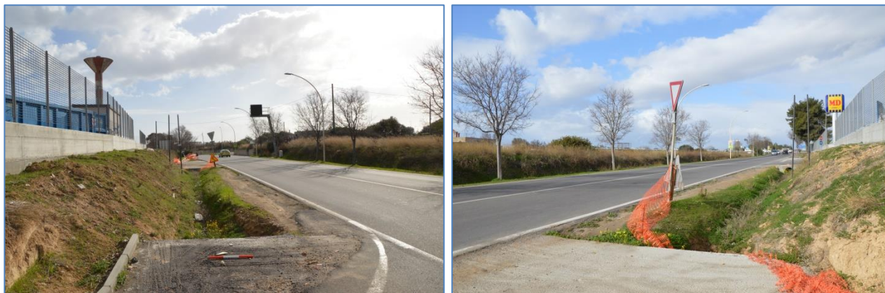
Fig. 13 e 14. Via Nenni. Limite SW del lotto, all'esterno del piazzale. La sezione verrà ridotta per fare spazio alla corsia di decelerazione. [Foto DSC_3546 da NW; Foto DSC_3550 da SE]
