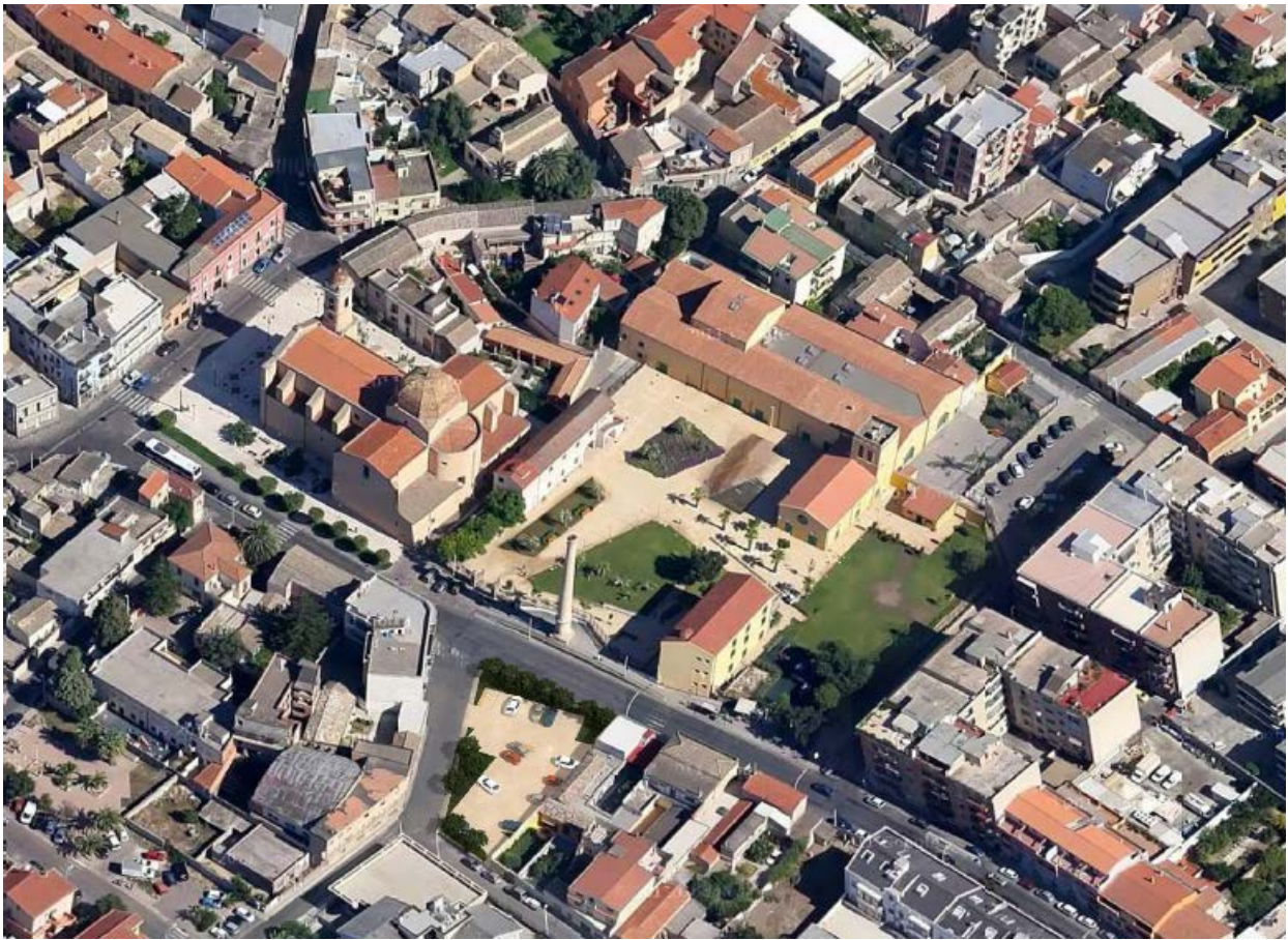
VISTA COMPLESSO DI SI E BOI POST INTERVENTO
