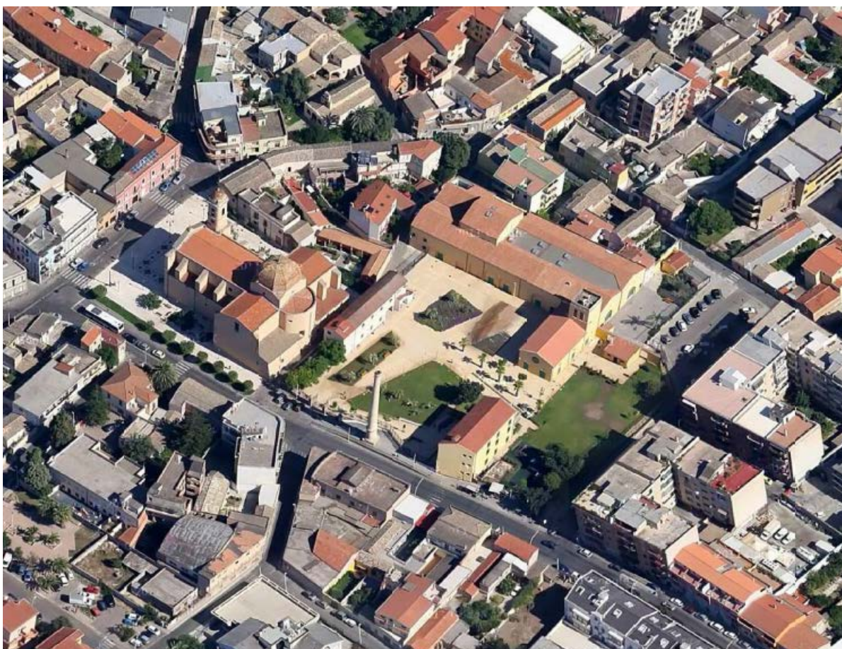
VISTA COMPLESSO DI SI E BOI ANTE INTERVENTO
