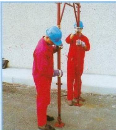
**2** Inserimento del telaio sulle basette
