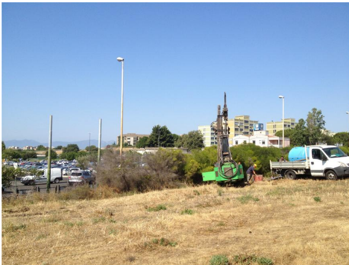
Figura 7 – Esecuzione dei sondaggi geognostici.
