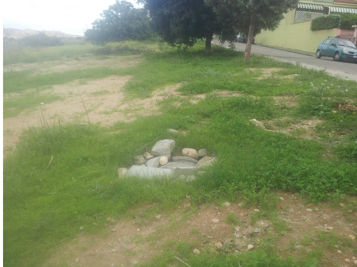
Foto 7 (Particolare pozzetto zona via Monviso)
