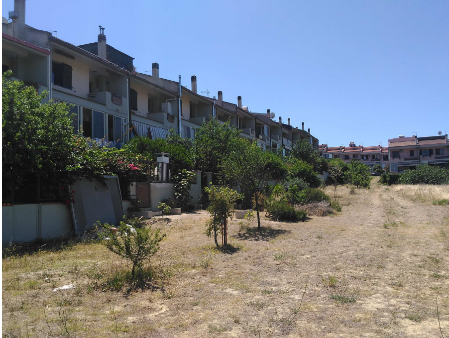
Foto 2 (Area realizzazione rete acque bianche, via Monte Gran Sasso)
