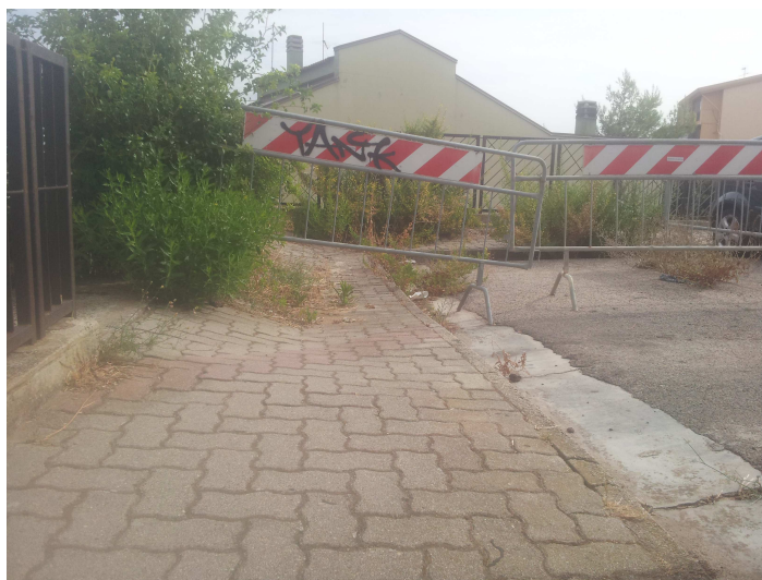
Foto 5 (Particolare marciapiede via Gennargentu)
