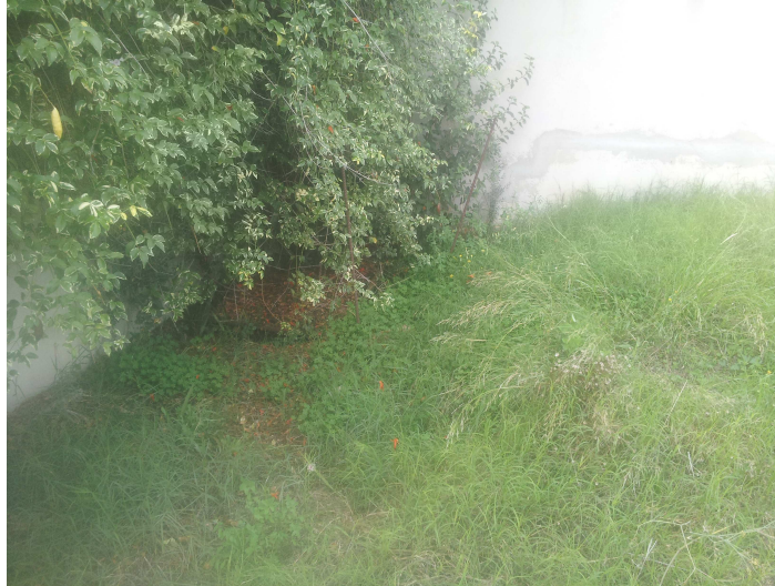
Foto 4 (Compluvio area a verde via Monte Bianco- particolare caditoia esistente)
