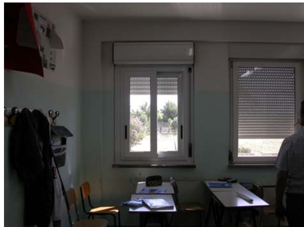
Infisso monoblocco di recente posa in opera
