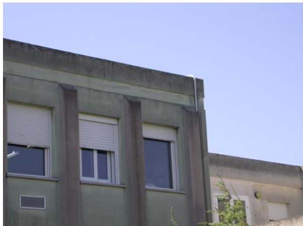
Tipologia infissi originali e di recente sostituzione
